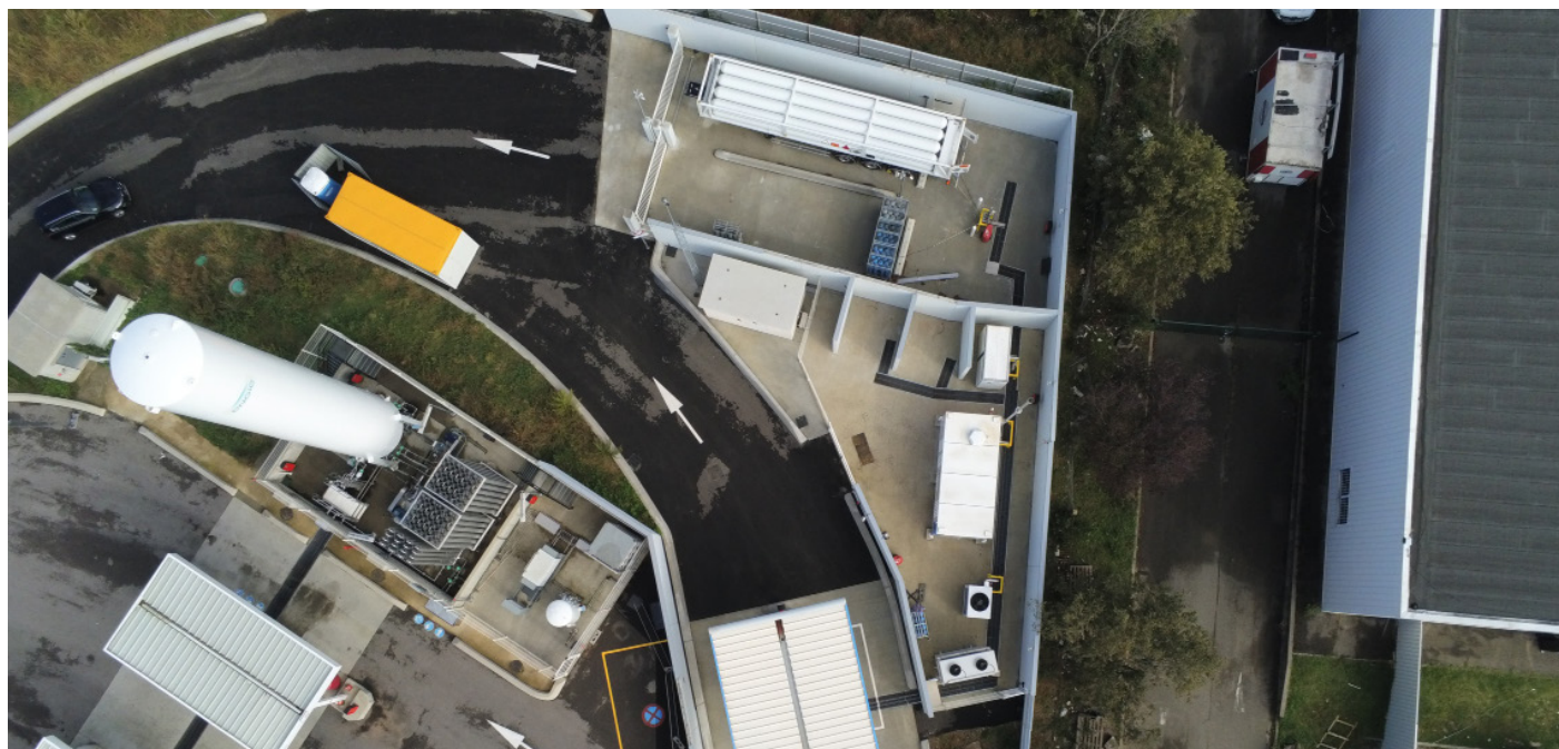
© HYmpulsion, station hydrogène à Saint-Priest, vue aérienne
