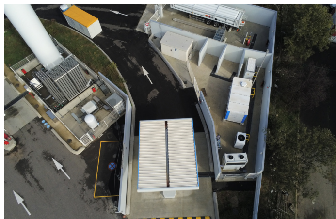
© HYmpulsion, station hydrogène à Saint-Priest, vue aérienne
