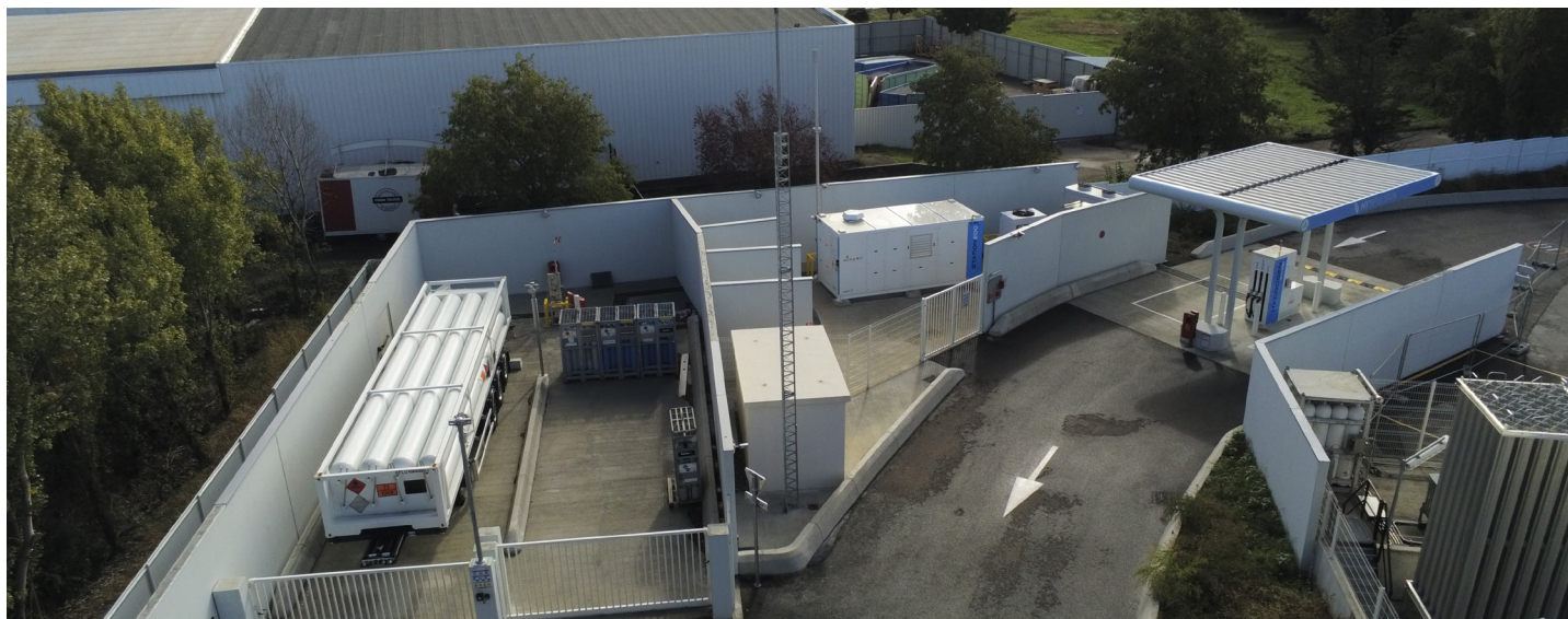
© HYmpulsion, station hydrogène à Saint-Priest, vue aérienne
