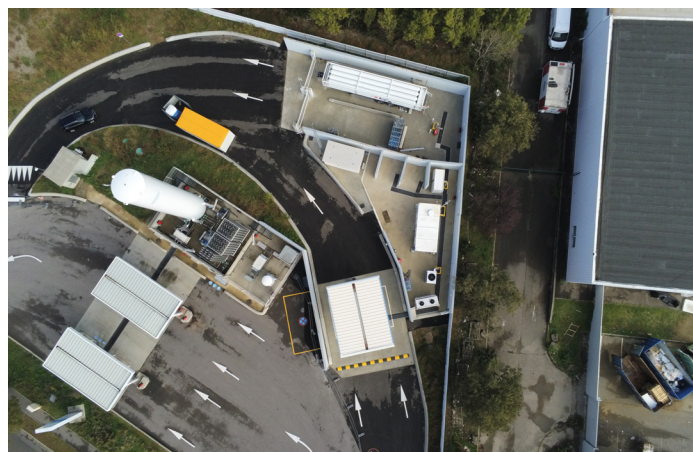
© HYmpulsion, station hydrogène à Saint-Priest, vue aérienne
